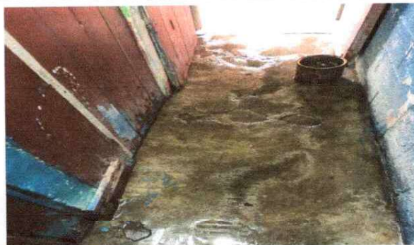
Foto 4: Sustitución de piso de los baños
