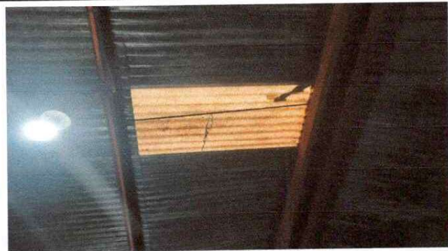
Foto 1 : Sustitución de techo del aula de Primero Básico
