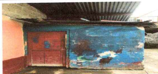
Foto 5: Sustitución de puerta principal, repello y cambio de techo del baño.
