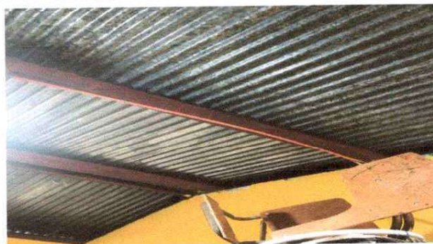
Foto 2: Sustitución de techo del aula de Segundo Básico
