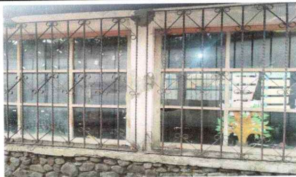
Foto 8: Sustitución de ventanales en el aula de Segundo Básico.
