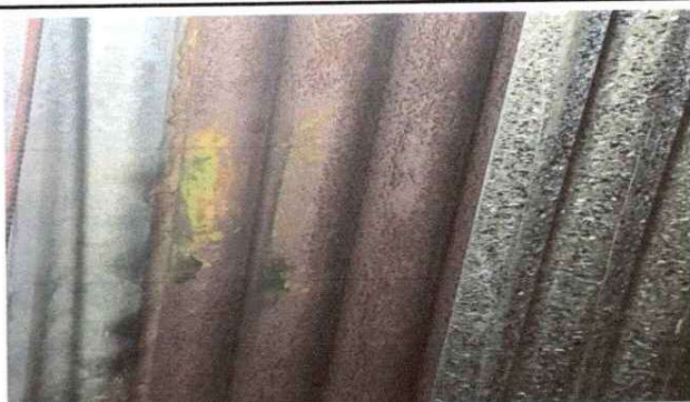
Foto 3: Sustitución del techo del aula de Tercero Básico
