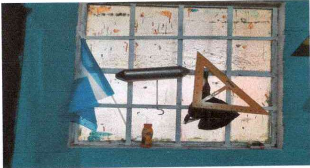
Foto 7: Sustitución de ventanales en el aula de Primero Básico
